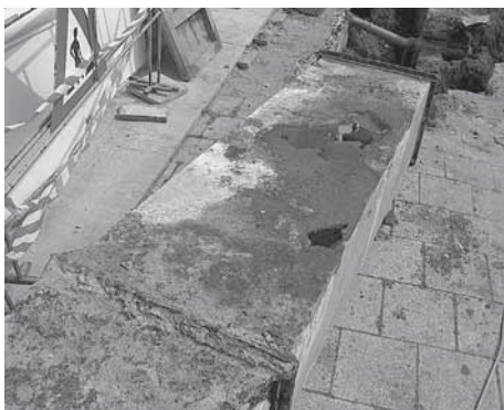
Staré potrubí, kterým se doposud přiváděl ohřátý vzduch do kostela.
